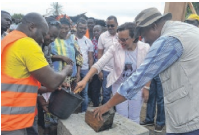
Madeleine Berre pose la première pierre de construction des trois passerelles.
