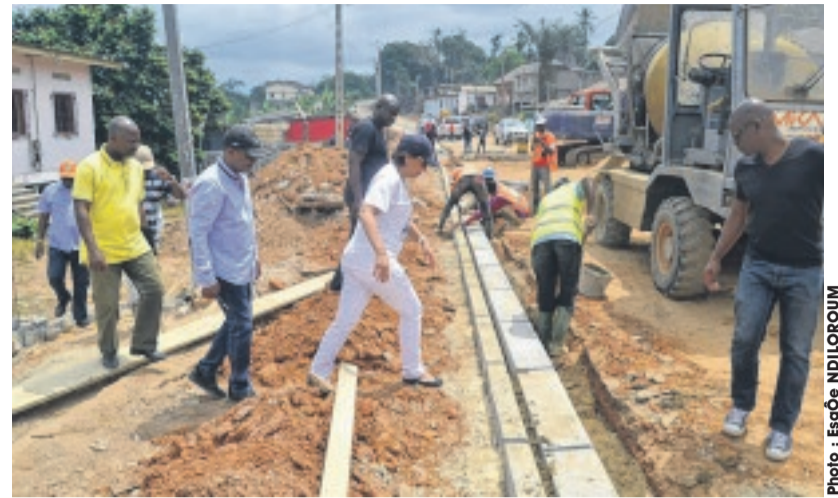
... a visité tous les chantiers...
