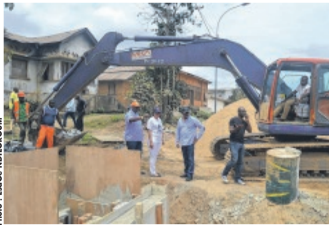
... en cours de réalisation.
