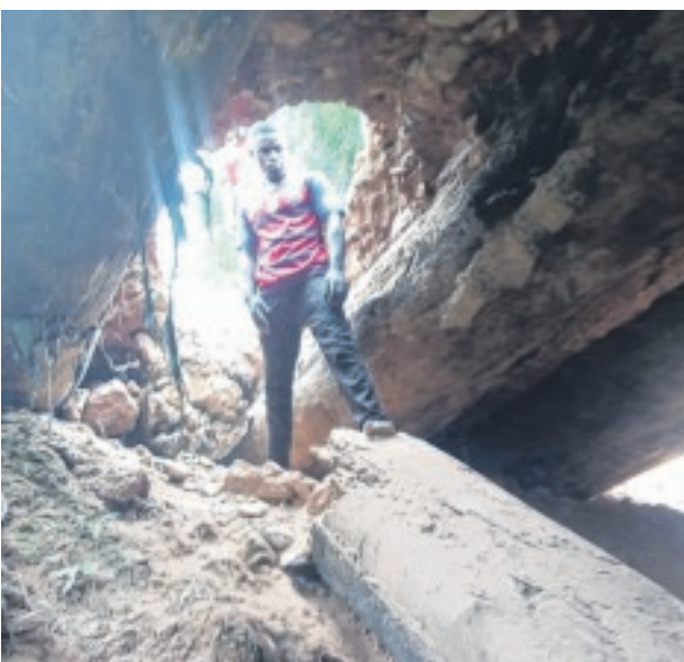
Le pont vu de dessous.
