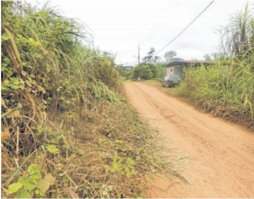
L'état de la route dans la zone de Bissobinam.
