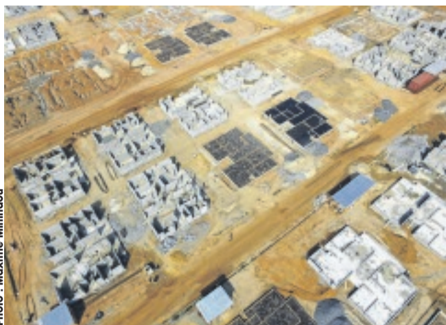
Une vue aérienne des logements en construction.
