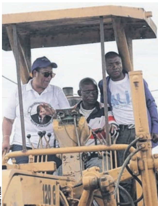
... du lancement des travaux des axes Angondje-Cap Caravane et Angondje-village.
