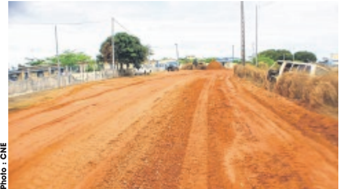
Le niveau de circulation est déjà bien meilleur qu'auparavant sur la route de Derrière-la SEEG.
