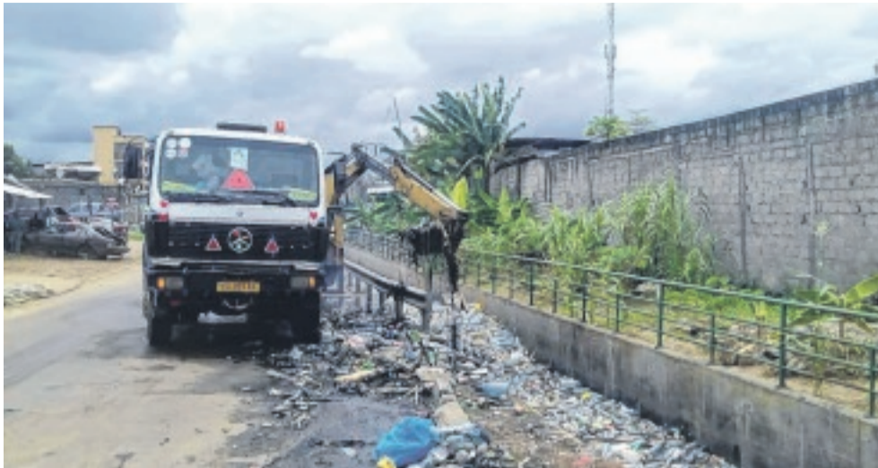
Lors de la phase de curage du canal allant vers le Foyer de charité.
