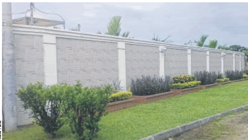
Une barrière embellie de carreaux muraux.
