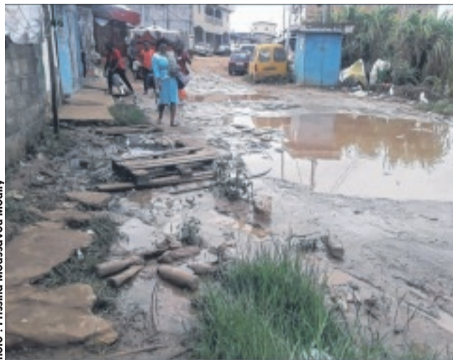
Au quartier Ambowe-cimetière, la route est dans un état de dégradation, surtout en saison pluvieuse.
