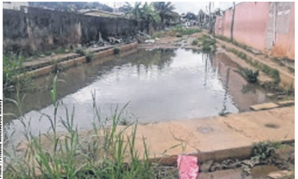
Au quartier Sibang, la voie passant devant le lycée Jean-Baptiste Obiang Etoughe est impraticable.
