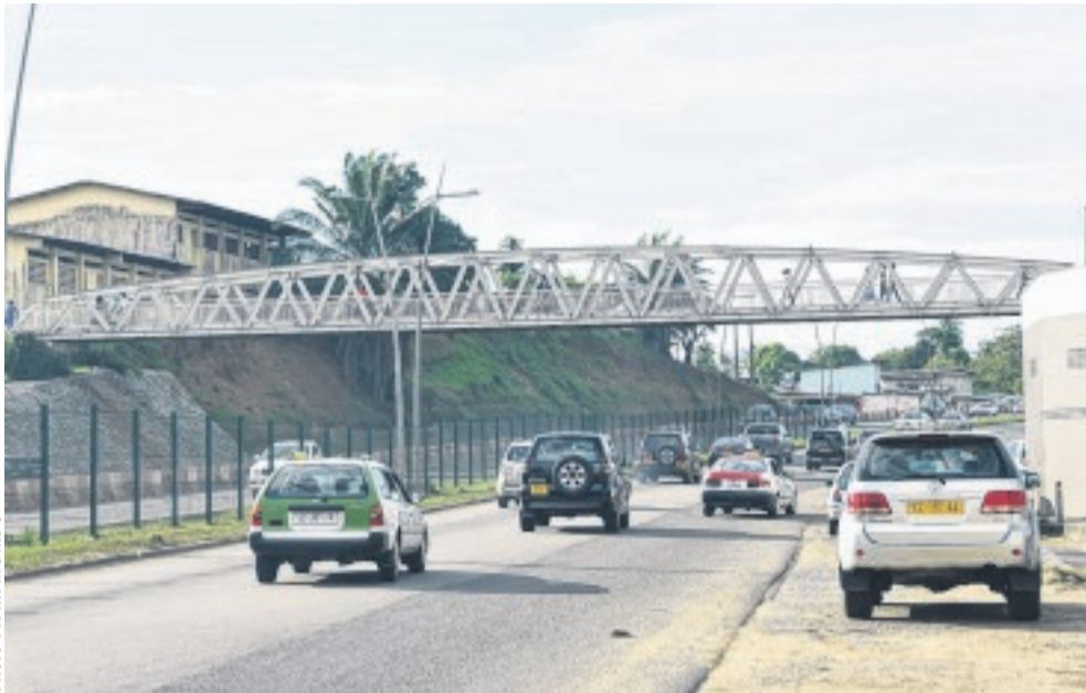
Malgré la construction d'une passerelle, les piétons prennent toujours le risque...
