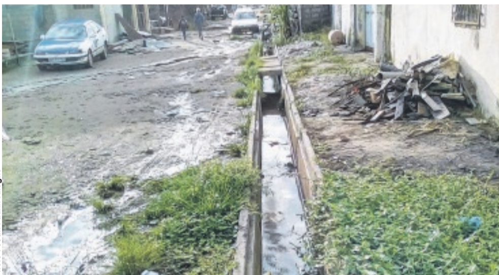
Vue d'une artère dont les travaux sont à l'abandon.
