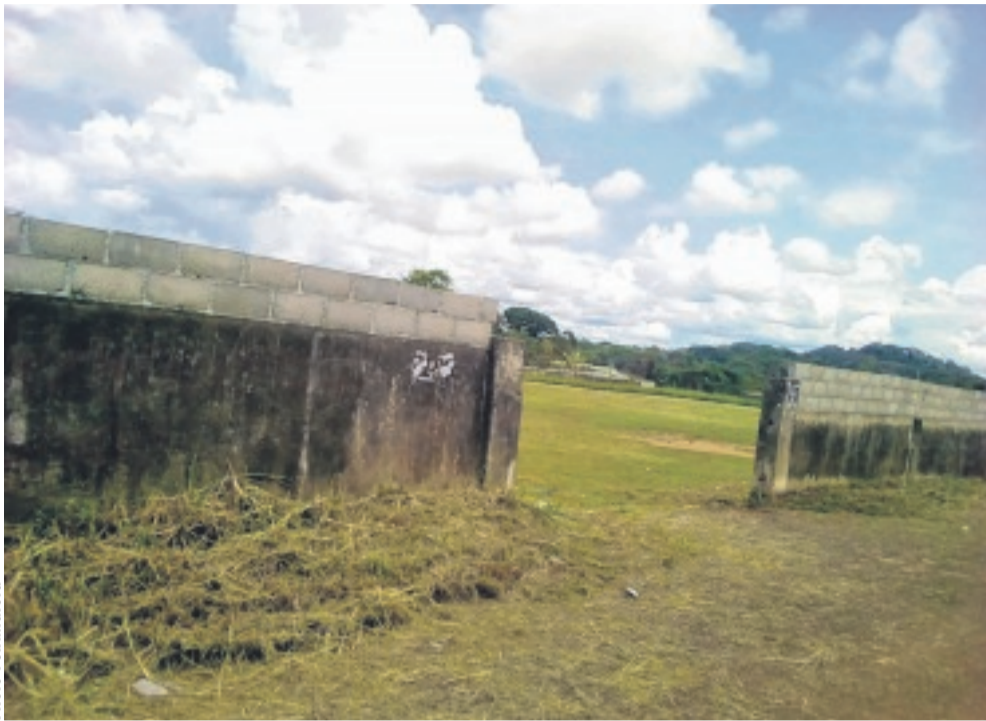
Les entrées principales du stade sont désormais sans portails.
