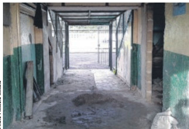
Le tunnel menant au terrain a subi un lifeting.
