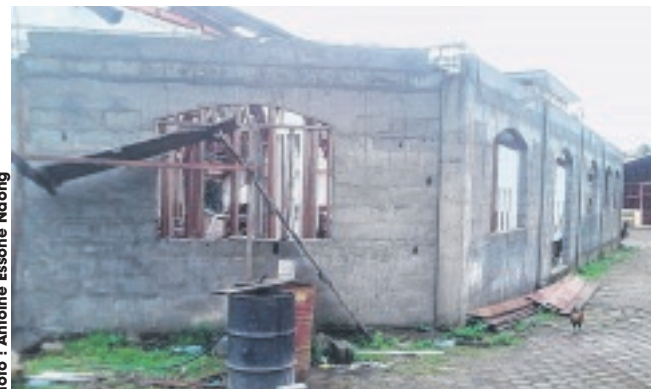
Sur le flanc droit de l'église, les murs sont déjà sortis de terre.
