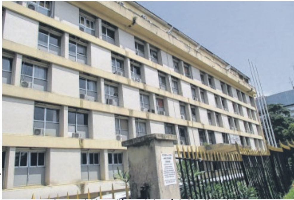
Le comptable-matières est chargé de faire l'inventaire du patrimoine immobilier de l'Etat.
