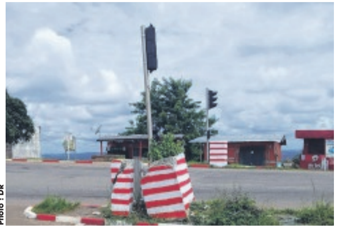
Cela fait plusieurs mois que les feux tricolores du carrefour Sogafric sont en panne.
