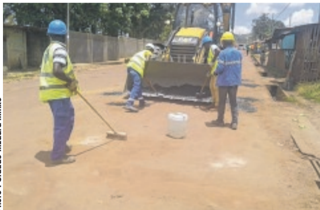
Les ouvriers procédant au bouchage...
