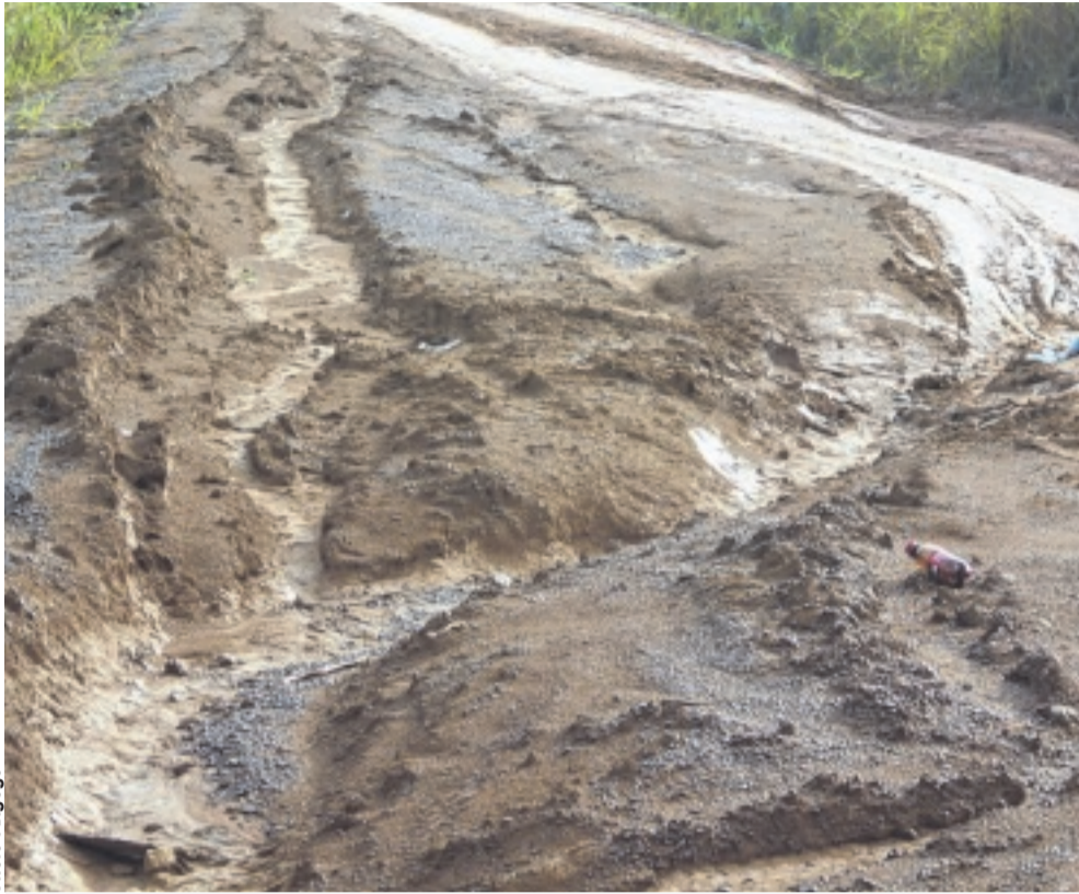
Voilà ce à quoi ressemble la route reliant Lébamba au village Kanda.
