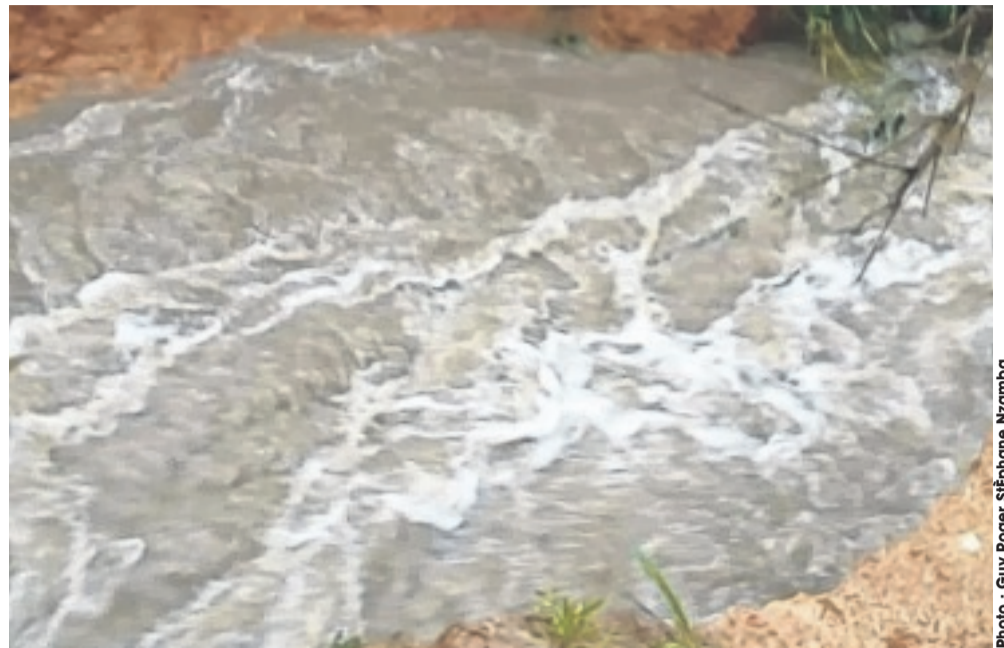
La puissance des eaux a emporté la vieille buse.
