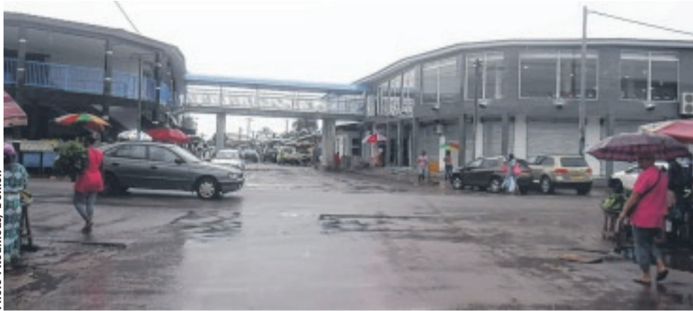
Vue extérieure du nouveau marché de la Balise.
