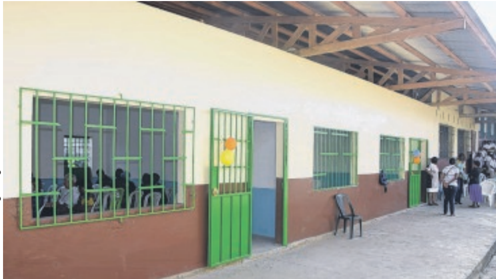
Ces deux salles de classe ont été entièrement réhabilitées par les éléments français au Gabon.
