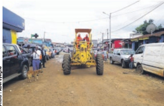
Un engin des travaux publics à pied d'œuvre.
