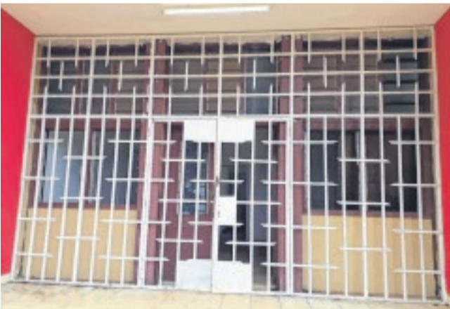
L'entrée principale du bâtiment abritant Radio 6 complètement barricadée.
