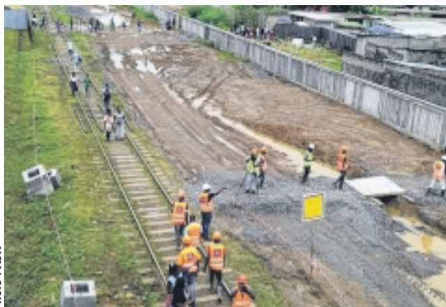
Vue d'un chantier en cours sur les installations de la Setrag.
