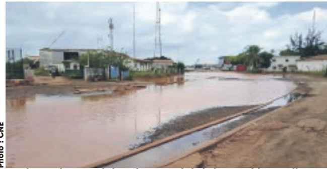
...la route conduisant au port, totalement impraticable aujourd'hui.
