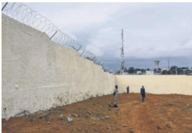
Une barrière haute de 12 m et épaisse de 40 cm pour renforcer la sécurité du pénitencier.
