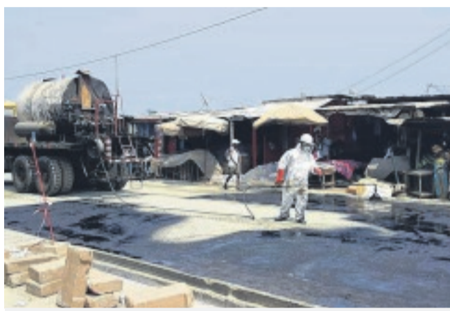
Aujourd'hui, ce carrefour est en travaux.
