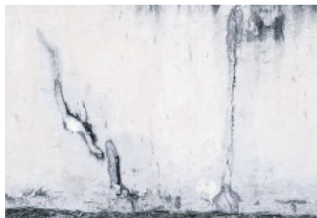
La clôture du gouvernement se fissure déjà.
