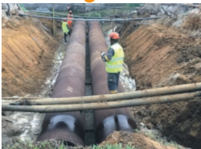
Le chantier a connu quelques retards en raison de ces câbles se trouvant dans son emprise.
