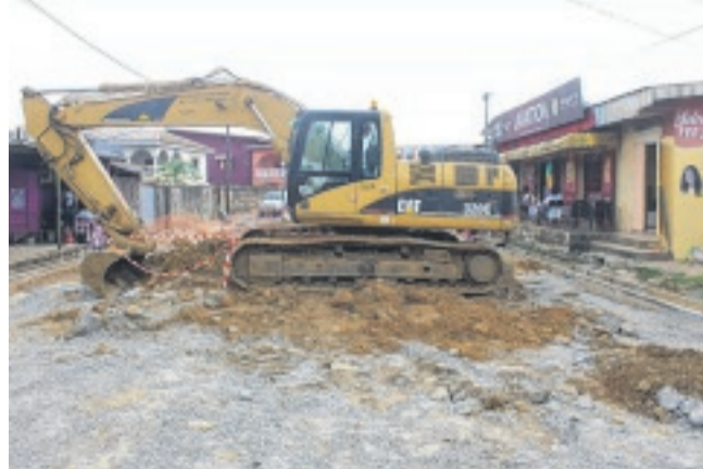
Entre temps, les travaux se poursuivent sur d'autres ruelles.
