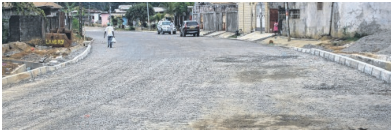
Ici, l'on attend plus que la dernière couche de bitume.
