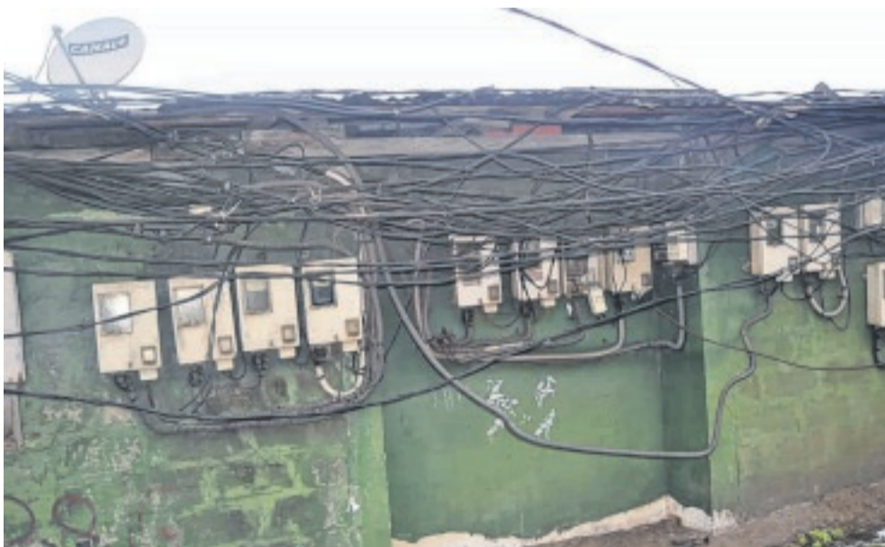
Une maison d'habitation aux allures d'une centrale thermique.
