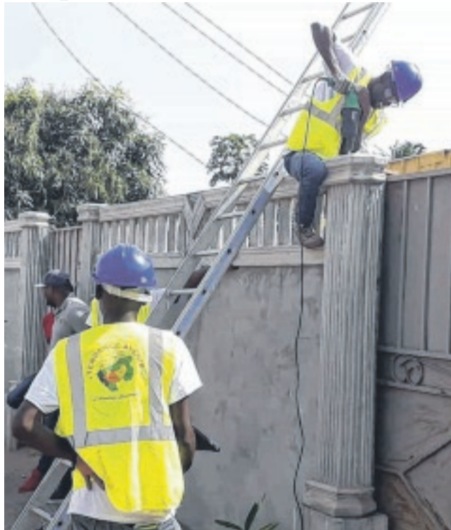
Des techniciens en pleine opération d'installation des panneaux solaires.
