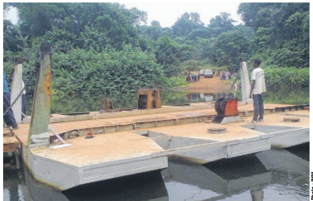
La réparation a consisté à remettre les câbles du système mécanique en l'état.
