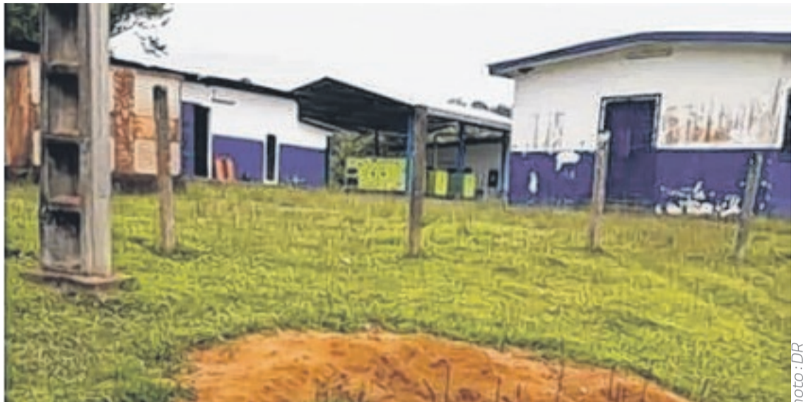
Vue de la centrale électrique de Mimongo.
