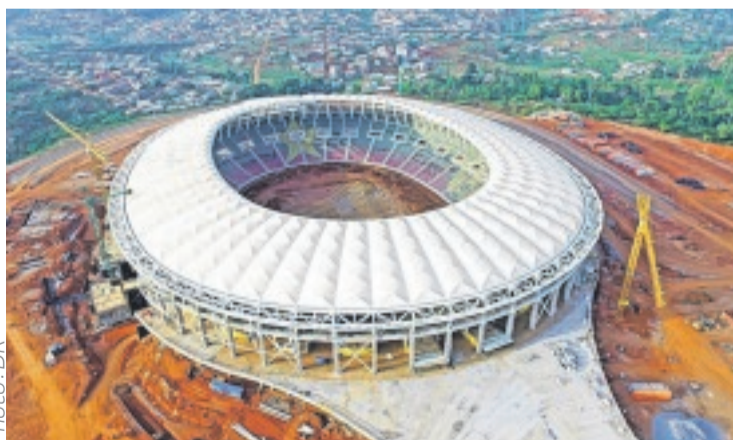
Les travaux du stade d'Olembe seront-ils terminés au mois d'avril prochain ?
