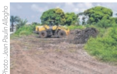
Photo: Jean Paulin Allogho Les engins de la mairie lors du nettoyage de l'espace.
