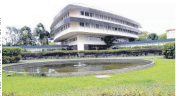
Le bâtiment administratif de Total Gabon.
