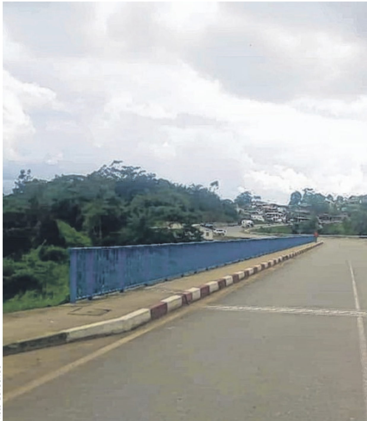
Une vue du pont de Ndjolé sur la voie principale, complètement désert.
