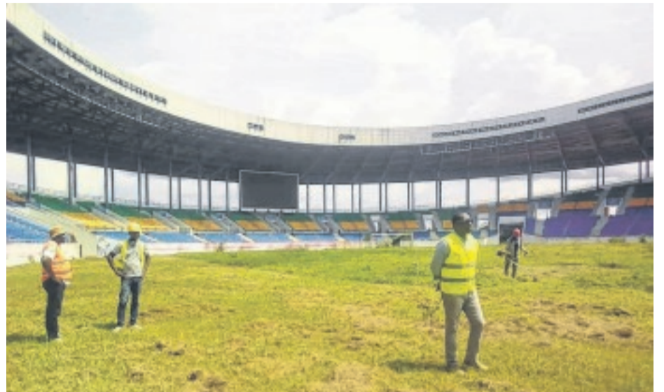
Les travaux de restauration du stade d'Oyem ont débuté.
