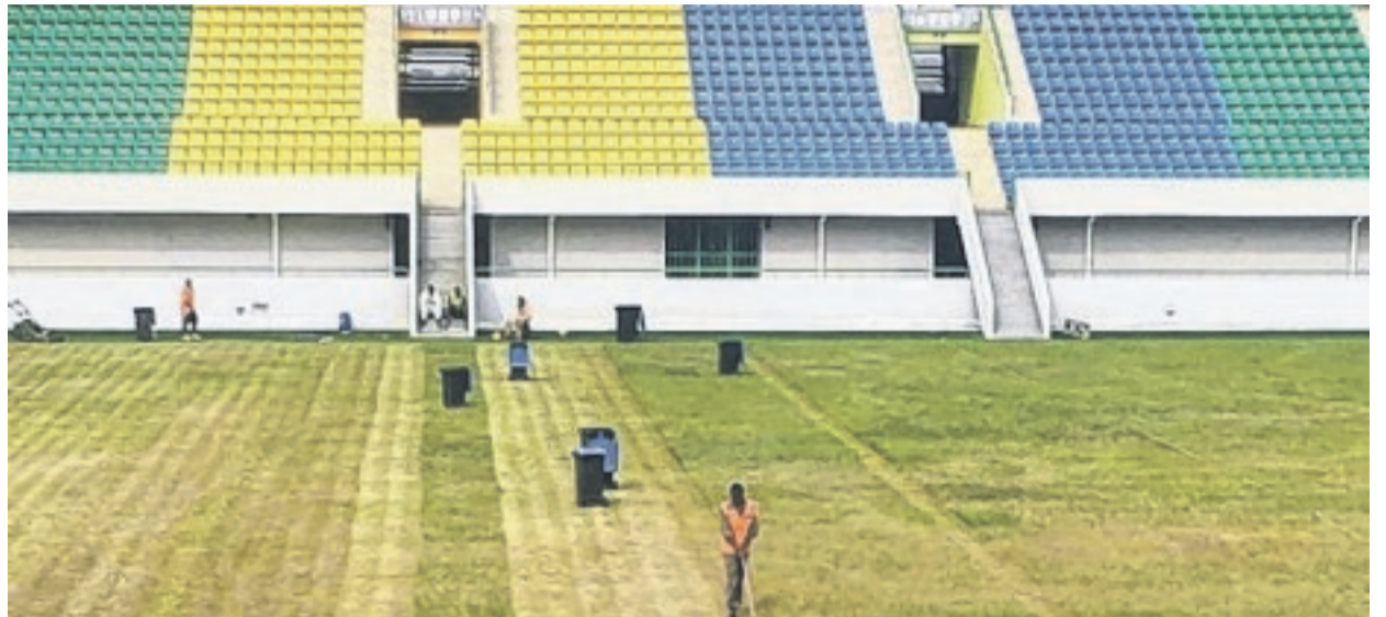
Le stade Michel-Essonghe en travaux. Ici, les ouvriers s'efforçant de remettre la pelouse en état.
