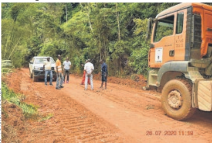
Les travaux sont effectifs sur la route de Mimongo.
