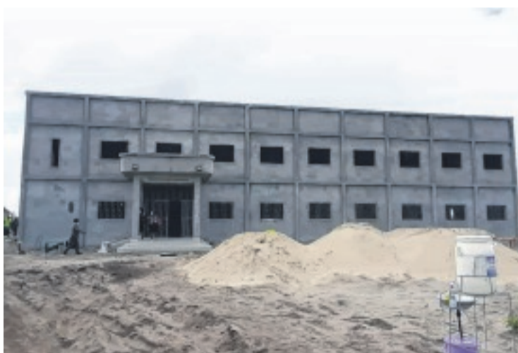
Les travaux de la Chambre provinciale des comptes ont avancé.
