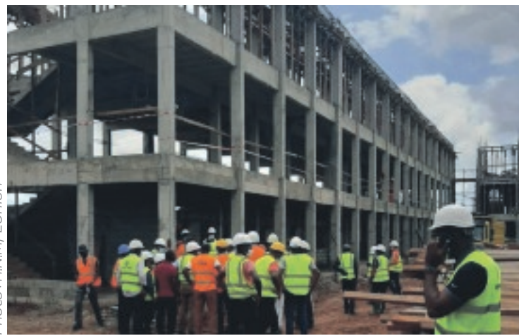
L'un des chantiers en cours du ministère de l'Éducation nationale.
