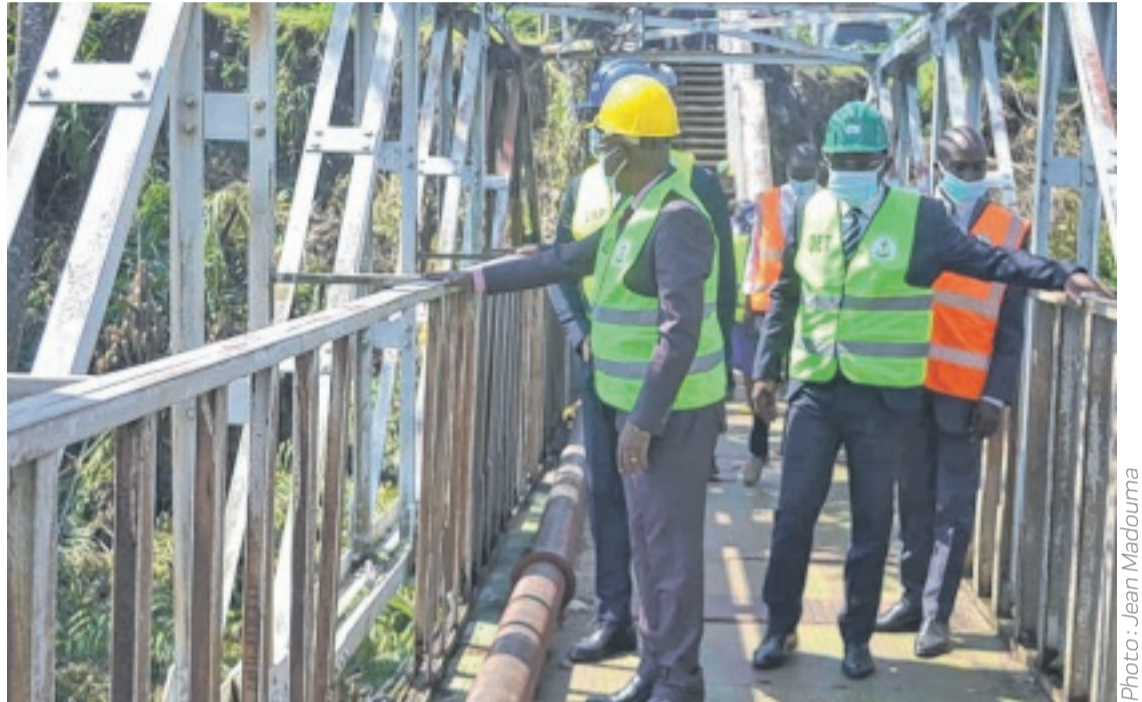
Le DG de l'Oprag, Appolinaire Alassa, sur le site en chantier.
