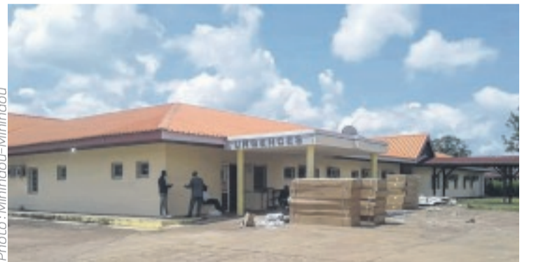
Vue partielle du centre hospitalier régional de Tchibanga.
