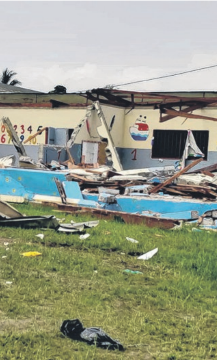
Centre scolaire que ces murs brisés.
