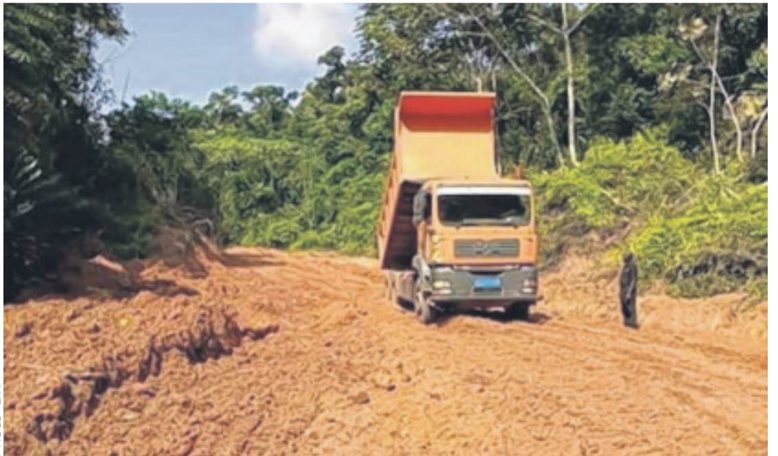
Une partie du linéaire actuellement en chantier.
