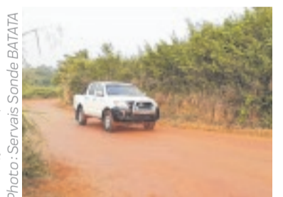
Vue du tronçon refait en latérite.
