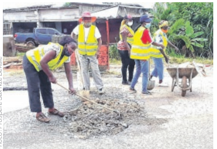
Les femmes de Nkok, en pleine action de bouchage de nids-de-poule.
