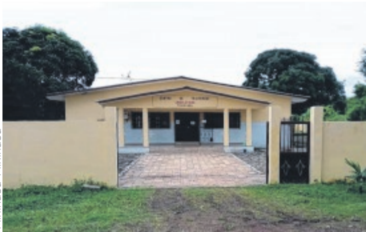
Vue du centre de traitement ambulatoire (CTA) de Tchibanga.
